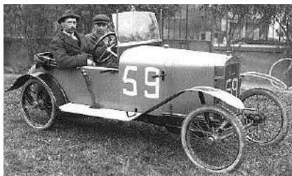
Marque créée par la société Blanc et Guillon, et reprise par Ernault Garage à Dommartin dans la Somme. La Tom Pouce était au début un cyclecar propulsé par un moteur deux temps de 730 cm<sup>3</sup>, remplacé par la suite par un moteur Ruby de 1 100 cm<sup>3</sup>. Une de ces voitures, pilotée par Blanc
